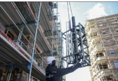
1. Für einige der Geberit GIS IV Wände ging es mit dem Kran hoch hinaus.
