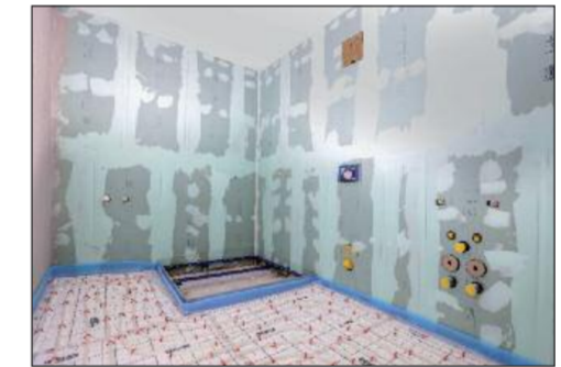
6. Nach der Installation der vorgefertigten Sanitärwände wurden diese beplankt.
