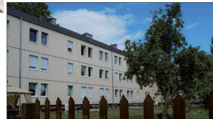
Die holzbasierten Fassadenmodule (hier die neue Fassade nach der Montage) enthalten schon Fenster und Rolllädenkästen sowie ein dezentrales Lüftungssystem.
