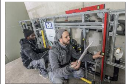
3. Nach der Befestigung wurden die Geberit GIS IV Wände ausgerichtet und ....
