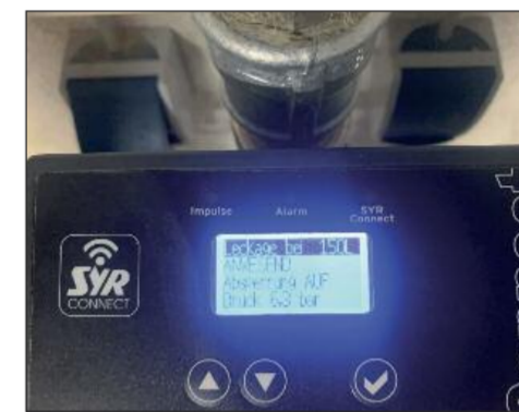
Sowohl über das Display als auch über die SYR App lässt sich der Safe-T Connect Slave ganz einfach steuern.
