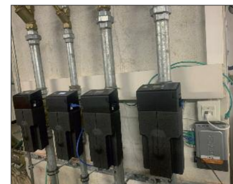
Die Leckageschutzgeräte Safe-T Connect Slaves sperren bei einer Leckage in einem der vier Abschnitte nur den betreffenden Strang ab.
