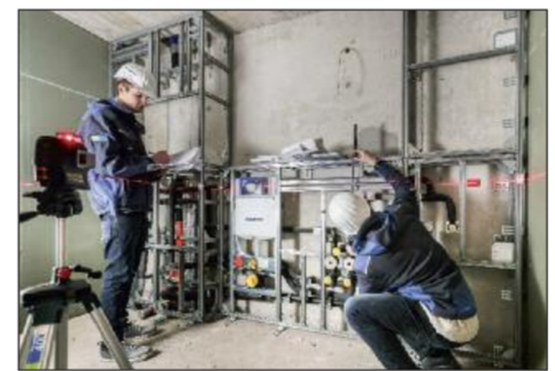
5. Das Register wurde dann vom Ingenieurbüro mithilfe eines Lasers geprüft und abgenommen.
