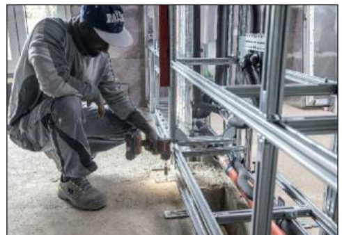
2. Die Geberit GIS IV Wände wurden in den Bädern vermessen und verschraubt.
