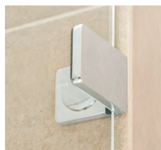
WANDMONTAGE: Rahmenlose Glaselemente werden mit einem Wandwinkel befestigt.
